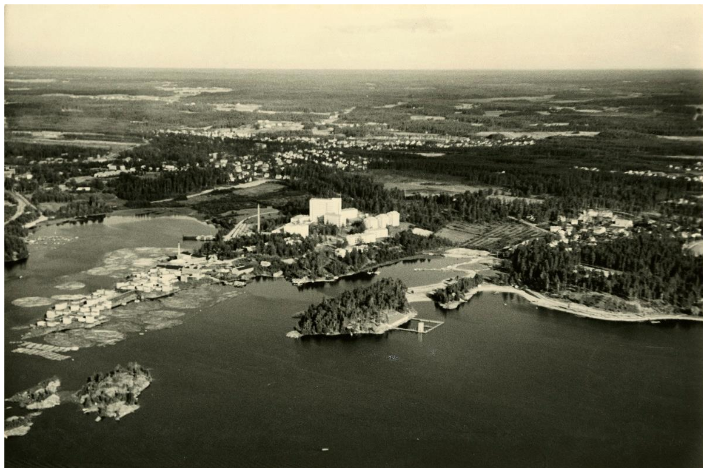
Ilmakuva Lappeenrannasta, keskellä Myllysaari ja keskussairaala.
